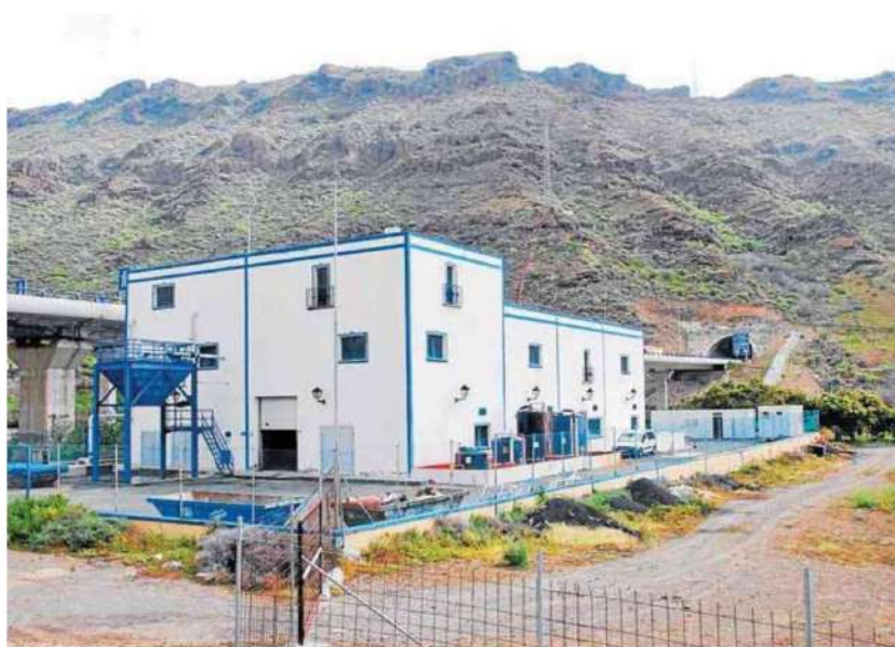
Vista de la estación depuradora de Playa de Mogán. c7
