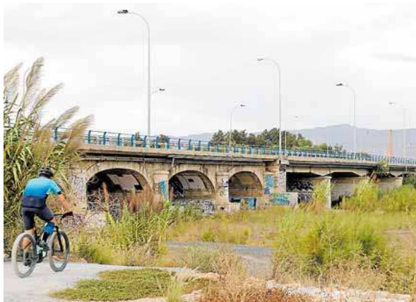
La obra contra la inundabilidad en el Bajo Guadalhorce, pendiente. MIGUE FERNÁNDEZ
