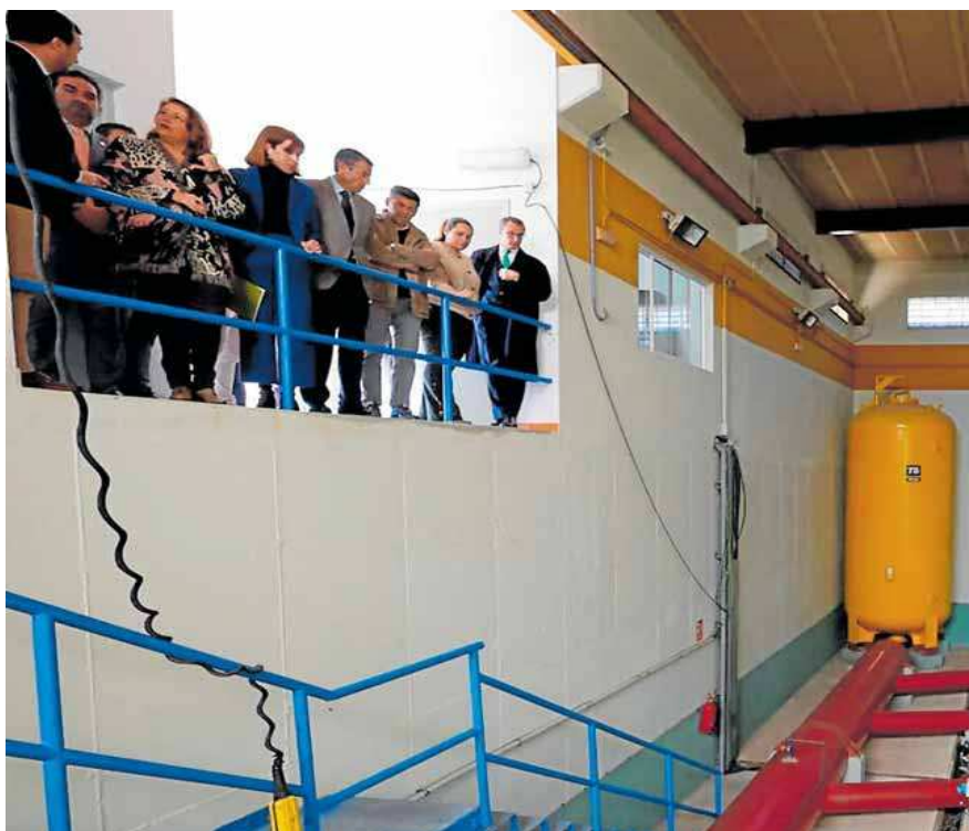
Está pendiente la mejora de las conexiones entre Málaga y la Costa. Y eso que la Junta ha duplicado el bombeo de
